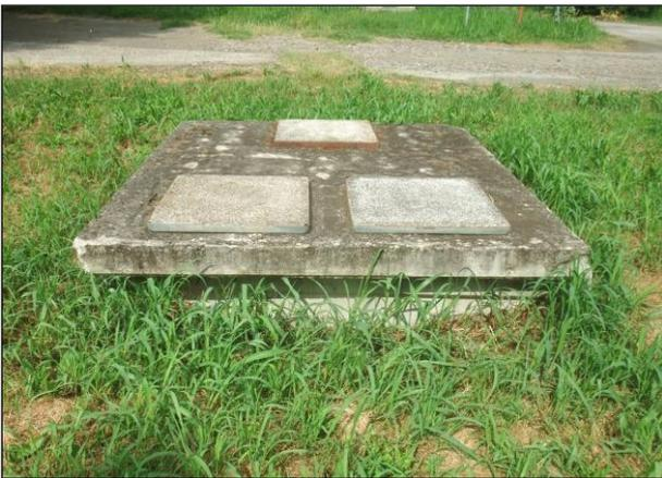
**Fig. 10: Pozzetto di raccolta**
