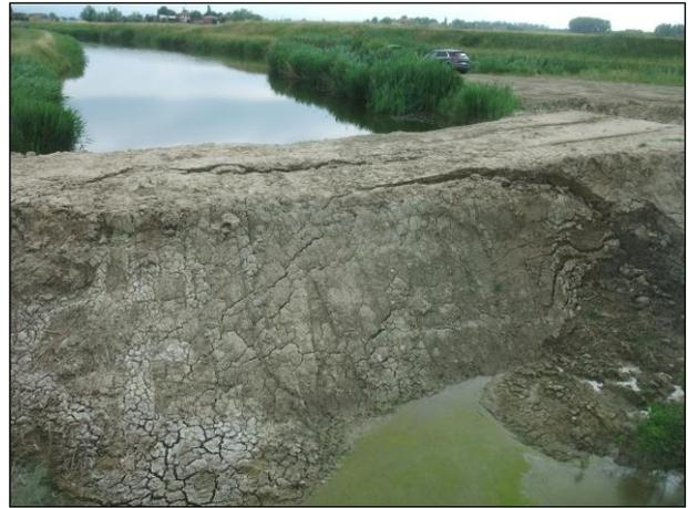
**Fig. 30: Vista del diversivo verso l'impianto "Il Conte" (argine provvisorio)**
