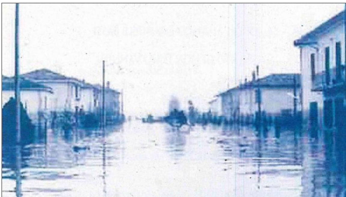
Fig. 10. Sala Bolognese. 1966. Alluvione (foto d'archivio)
