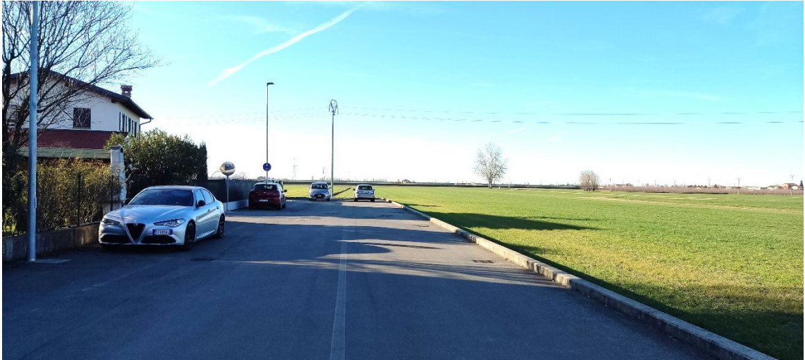
Fig. 2.5 –Via Caduti di Sabbiuono – Laterale di Via della Casetti
