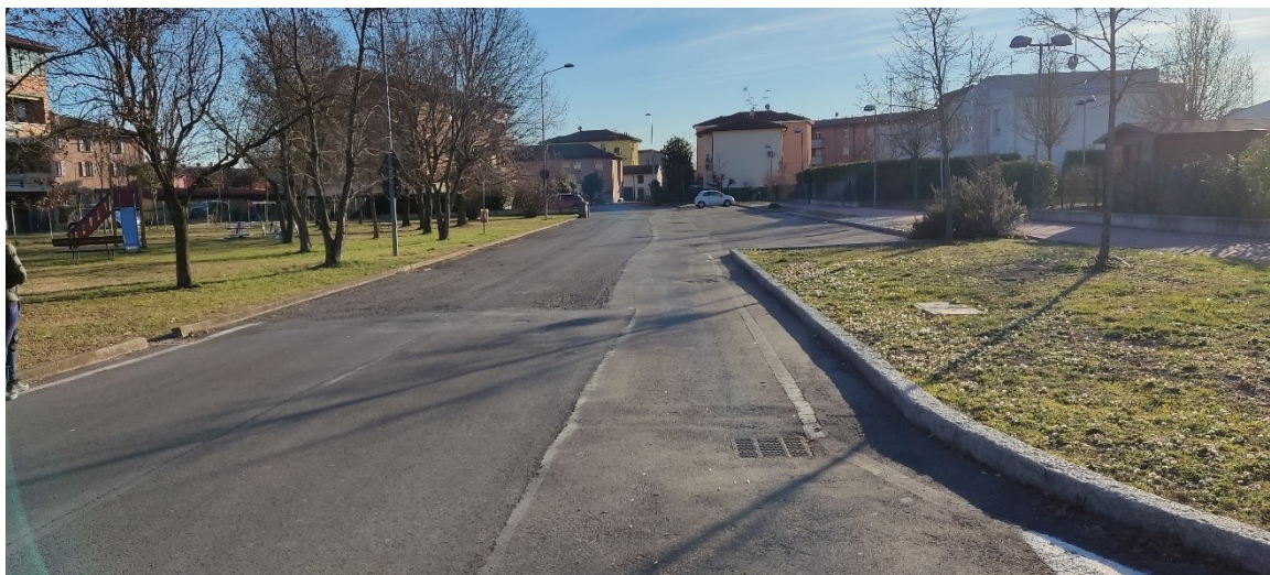
Fig. 2.2 –Via della Casetti (direzione sud)
