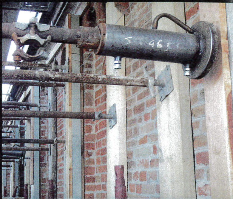
Vista dei martinetti predisposti per il raddrizzamento
