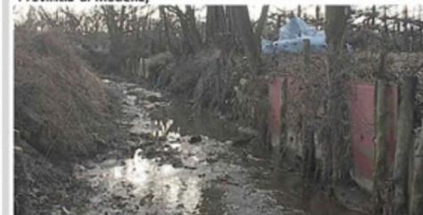
Il Canale di San Pietro prima dei lavori (2004); la sponda in erosione è sorretta in modo precario da una struttura non autorizzata costituita da legname, materiali metallizzati inerti...
