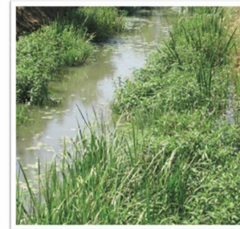
Modalità di gestione della vegetazione in alveo funzionale a massimizzare i processi autodepurativi. La vegetazione acquatica non è asportata totalmente, ma sono lasciate in alveo due strisce vegetate al piede della sponda. In questo modo le acque del canale possono attraversare, con velocità limitata, la zona vegetata e subire così i processi depurativi indotti da questo sistema fitodepurante naturale. (Foto: Consorzio di bonifica Acque Risorgive)
