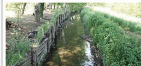
La sponda del canale protetta dalla palizzata rinverditata appare in buono stato, mentre le talee di salice non si sono sviluppate a sufficienza come conseguenza del taglio, non previsto dal progetto, effettuato dai proprietari del terreno. (Foto: Consorzio della bonifica Burana e Marco Monaci)
