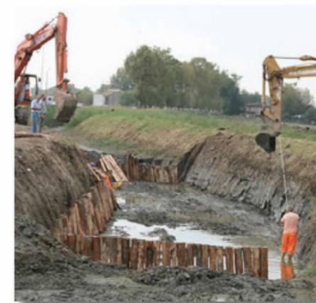
Trappola per sedimenti in fase di costruzione lungo il Canale di San Giovanni, al termine dei lavori di abbassamento del fondo alveo (2009). Si noti in primo piano e sullo sfondo, prima e dopo lo scavo, il livello del fondo del canale, superiore a quello presente all'interno della trappola. Il perimetro dello scavo è protetto, nel caso in esame, da paleria di castagno, per evitare il franamento delle pareti della trappola. (Foto: Marco Monaci)
