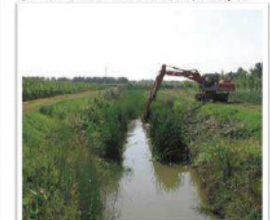
Il taglio della vegetazione con creazione di un canale di corrente riduce i rischi di danno al piede di sponda descritti nella figura precedente, proprio grazie al fatto che il piede non viene interessato dalle operazioni di manutenzione. (Foto: Consorzio di bonifica Acque Risorgive)
