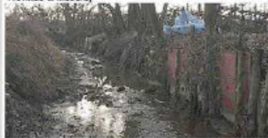
Palizzata rinvierita: Canale di San Pietro (Consorzio della bonifica Burana, 2000-05 - Comune Spilimbergo Provincia di Modena)
