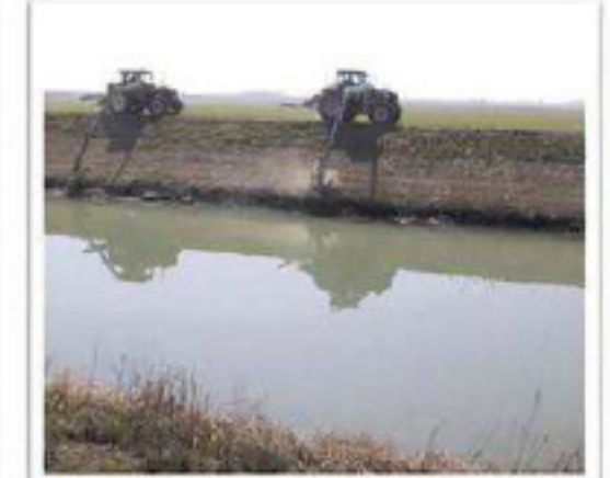
Nel corso delle tradizionali operazioni di sfalcio completo della vegetazione, il passaggio delle attrezzature di taglio sulla scarpata spondale provoca inevitabilmente danni al piede di sponda, che richiedono successivi interventi di sistemazione o riprofilatura. (Foto: Consorzio di bonifica Acque Risorgive)
