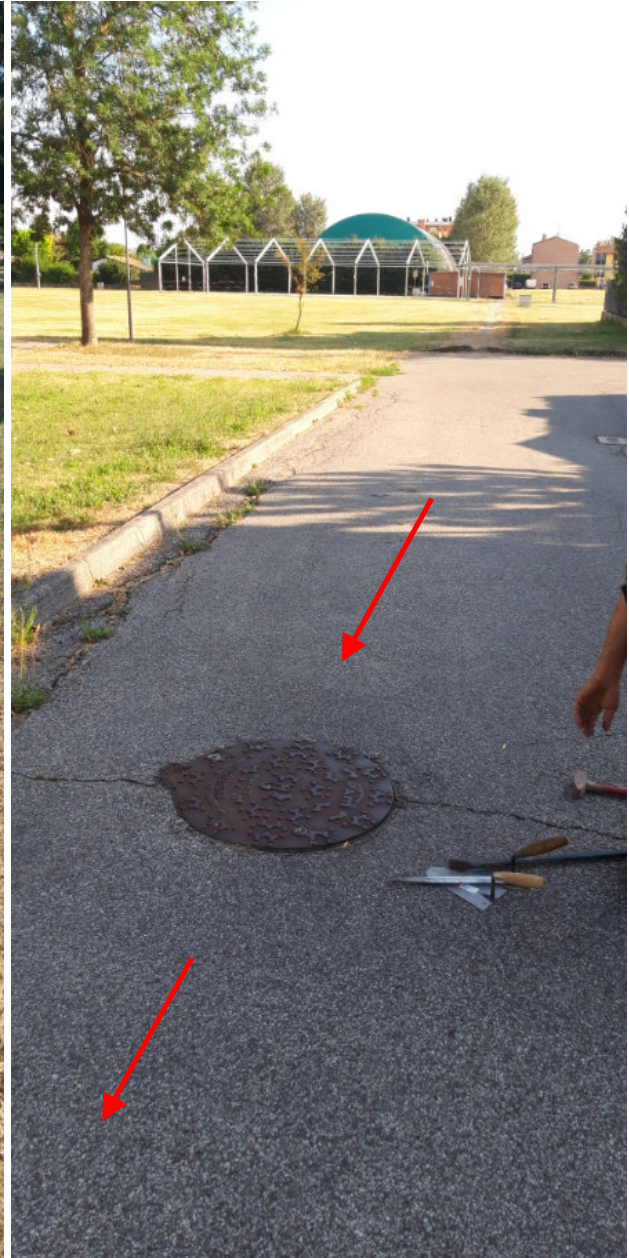
Pozzetto presente sullo scolo Fossandone
