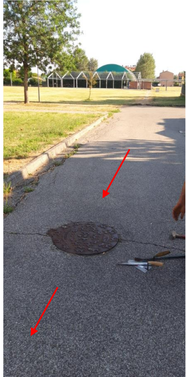
Pozzetto presente sullo scolo Fossandone
