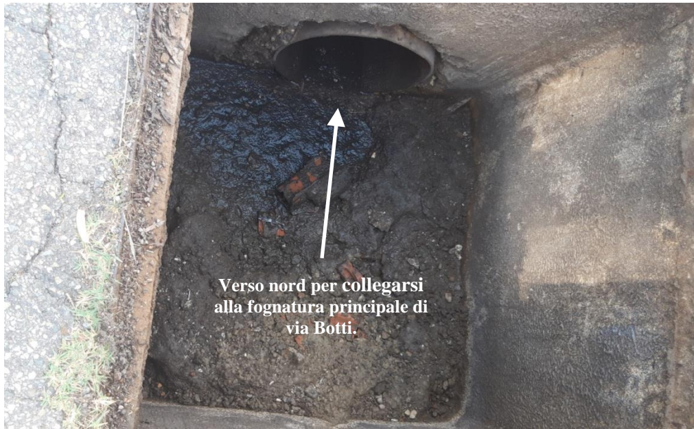
Pozzetto lungo via Botti che sarà il recapito della fognatura nera.
