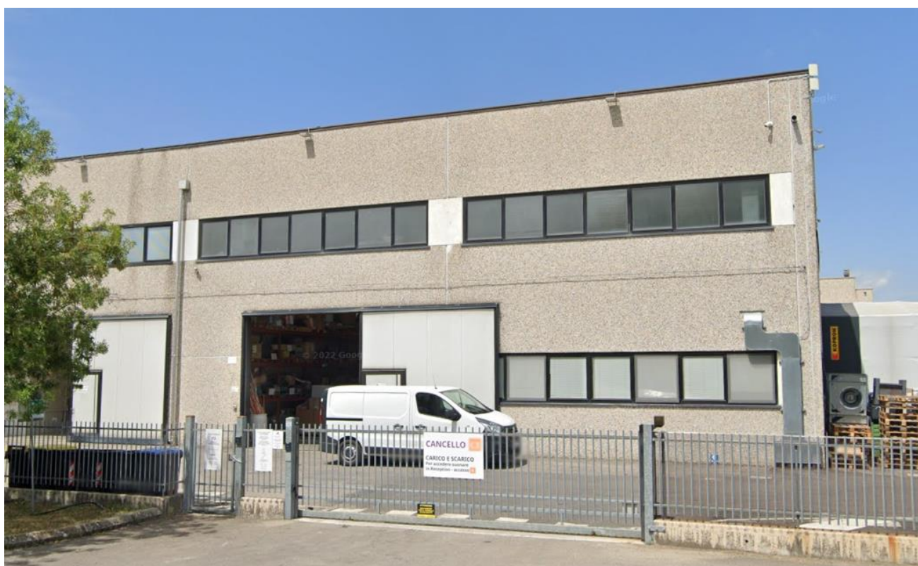
Esterno del Fabbricato (Foto 2)
