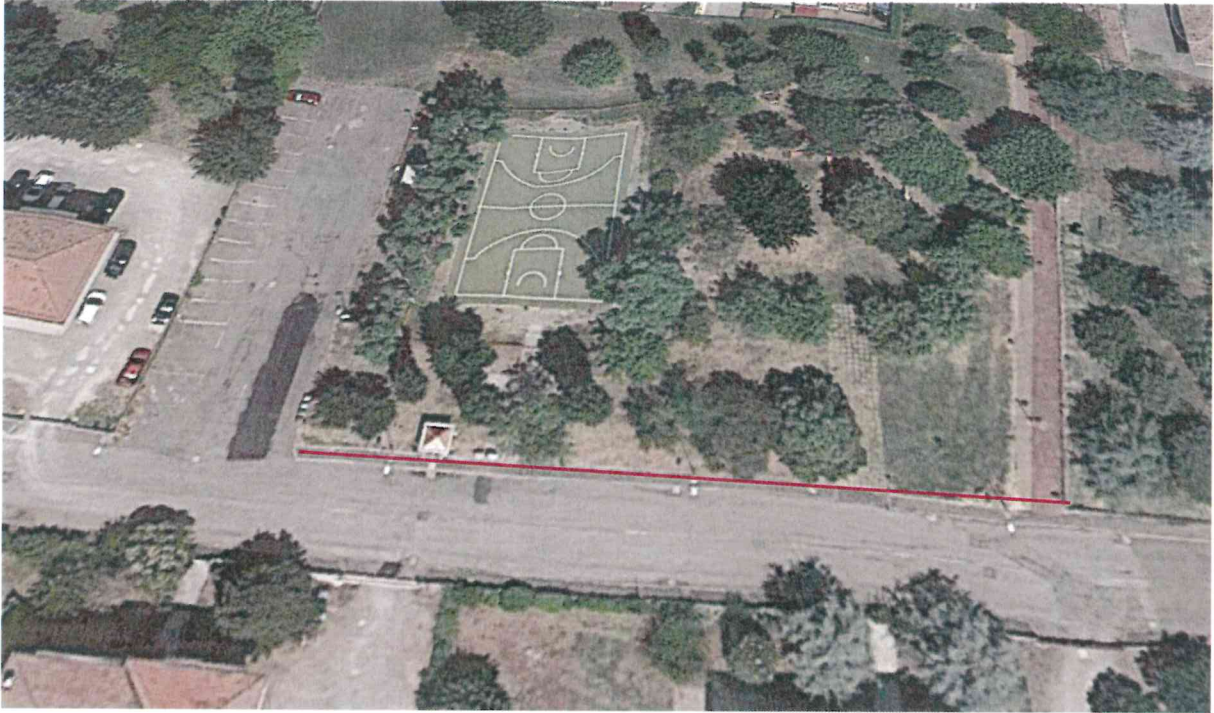
Fig. 5: Marciapiede Via De Gasperi
