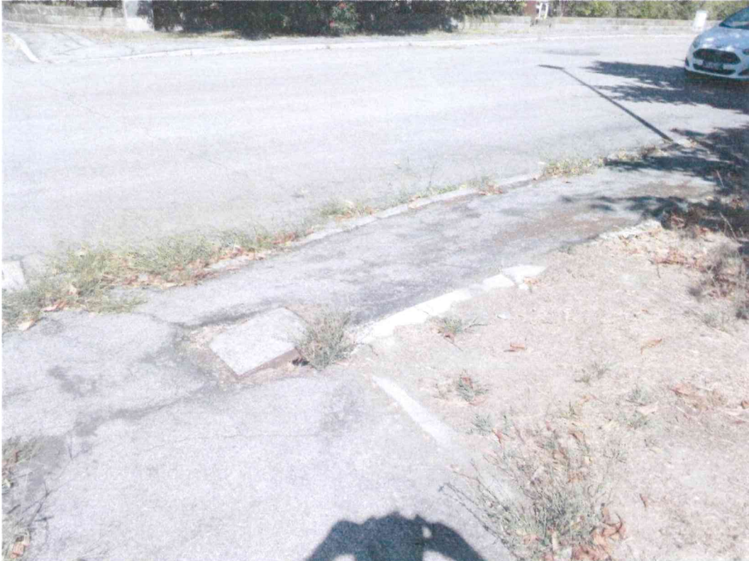
Tratto da demolire e ricostruire
