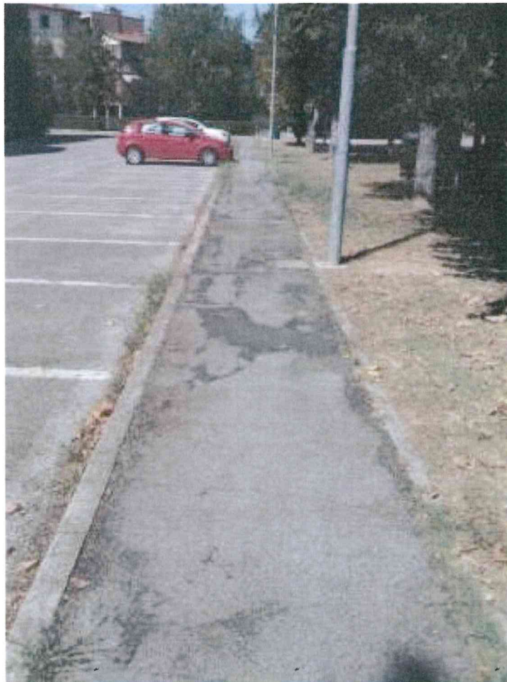
Tratto lato parco ovest
