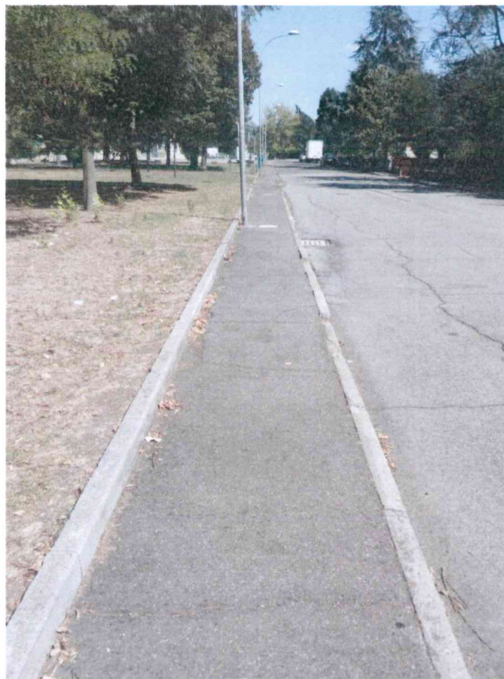
Tratto lato parco sud vista est-ovest
