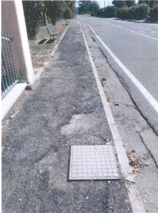
Tratto fronte civico 309/A
