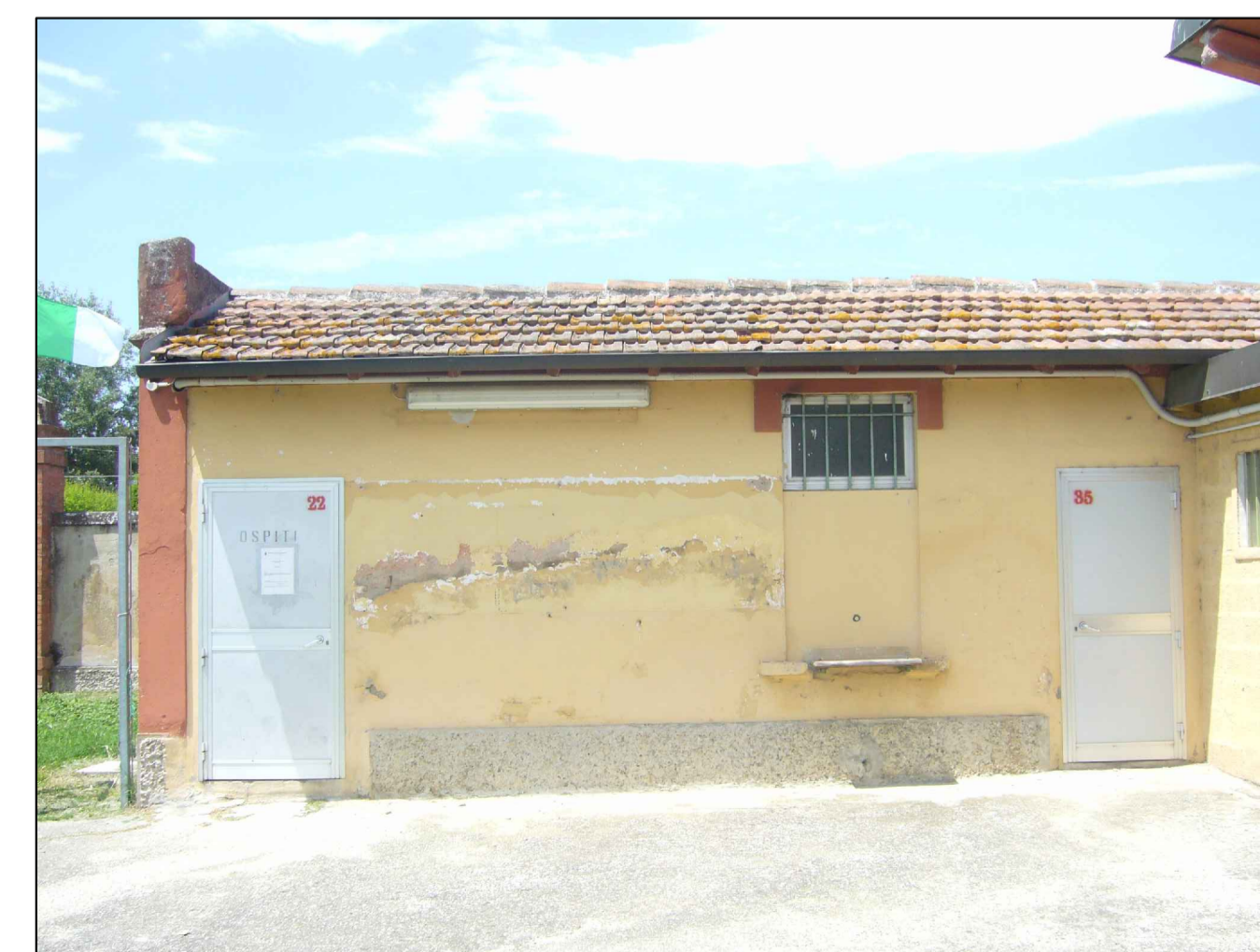
Foto 5 - Prospetto lato cortile
